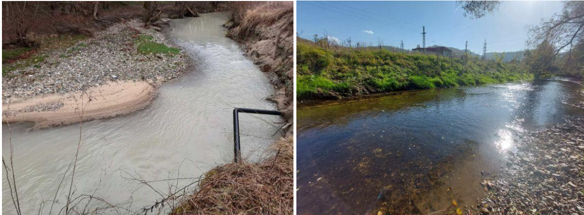
Slika 31 Lokacija 1. rkm 32+460 - 32+500 – plinska cijev unutar korita (lijevo) i pokos lijeve obale s vegetacijom studeni, 2022 (desno)
